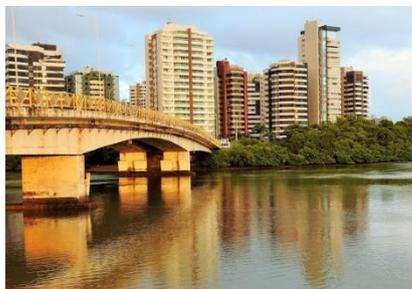
**Conceito do Projeto:** Projeto para instalação de equipamentos de iluminação na Ponte Godofredo Diniz, contemplando minimamente elementos de iluminação especial nas pilastras e na vista frontal dos arcos da ponte.
