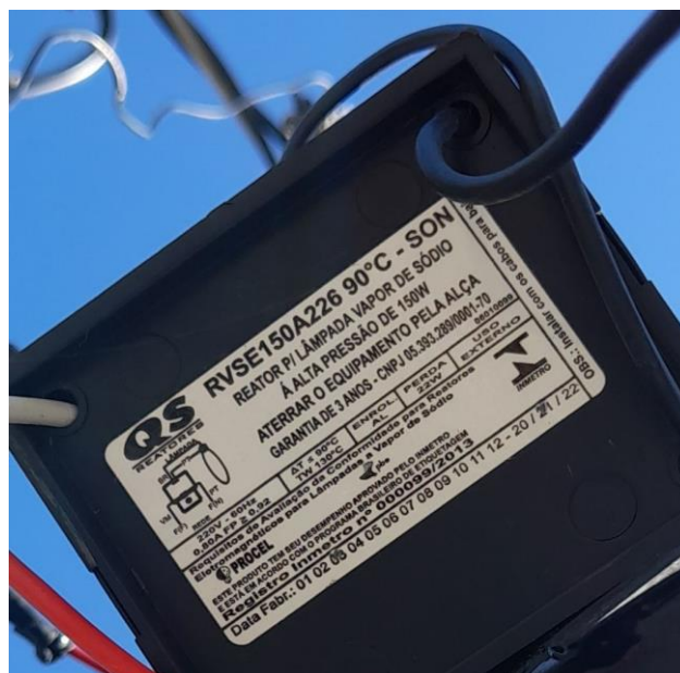
Figura 2: Exemplo de etiqueta de reator em que a potência da luminária é especificada.
